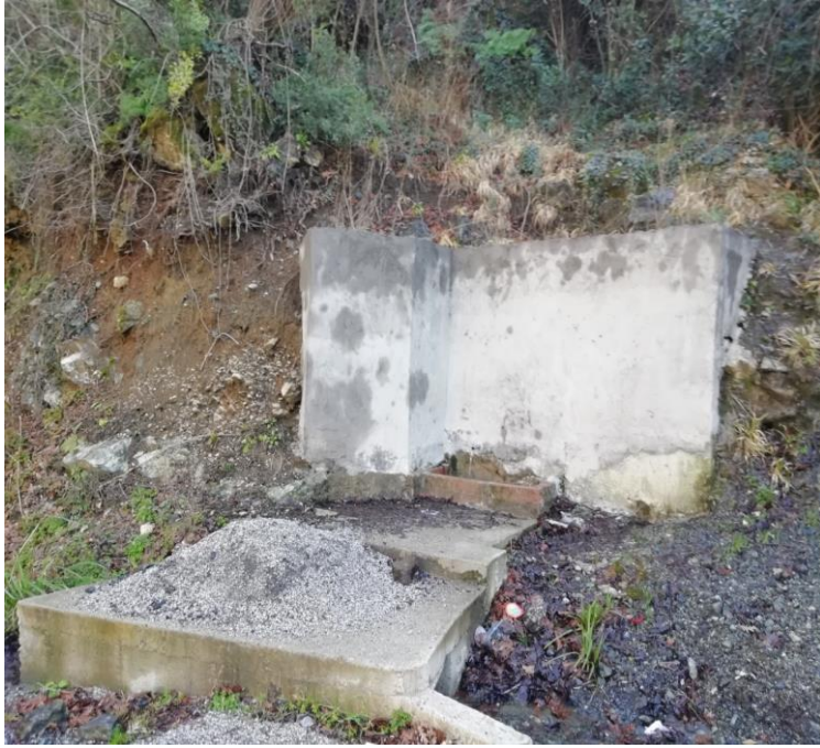
Resim 3. 3. A3 kodlu su kaynağından görünüm
