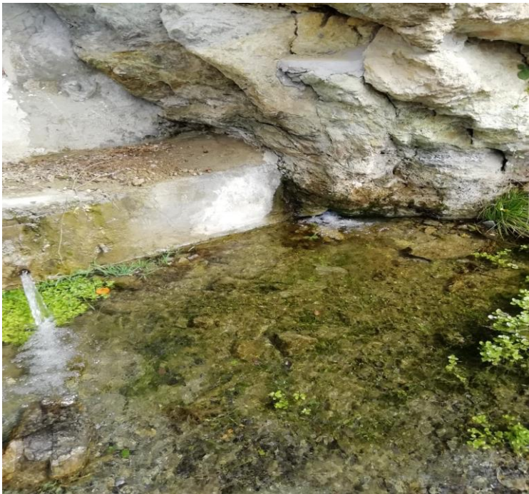
Resim 3. 2. A2 kodlu su kaynağından görünüm
