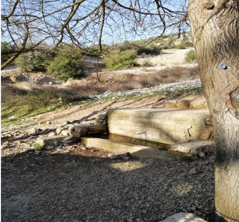
Resim 3. 9. A9 kodlu su kaynağından görünüm
