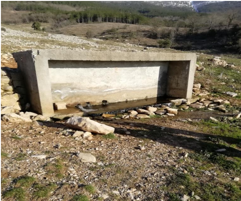
Resim 3. 11. A11 kodlu su kaynağından görünüm
