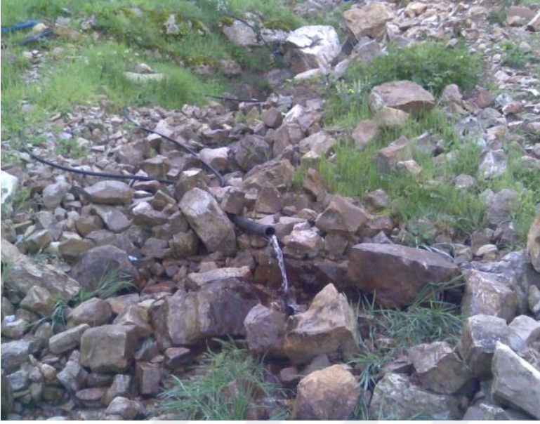
Resim 3. 6. A6 kodlu su kaynağından görünüm
