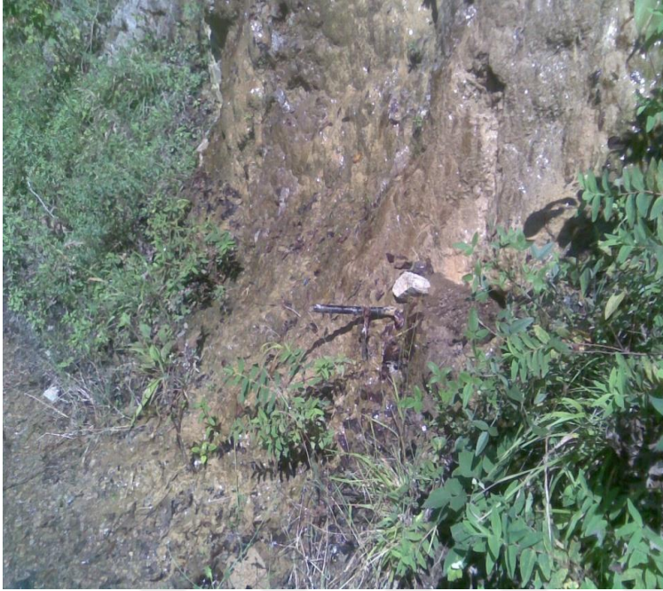
Resim 3. 1. A1 kodlu su kaynağından görünüm
