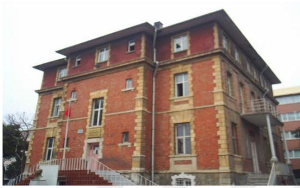
Resim 3.3. İncelenen yığma yapı (Öztaş, 2009)
