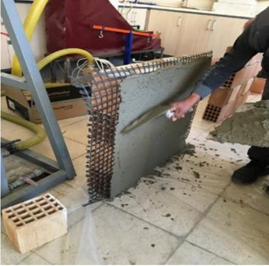
Resim 4.20. b) Uygulanan sıvanın mala ile yüzeyinin düzeltilmesi
