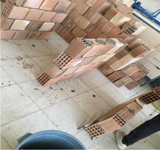
Resim 4.13.c) Tuğla duvarların örülmesi
