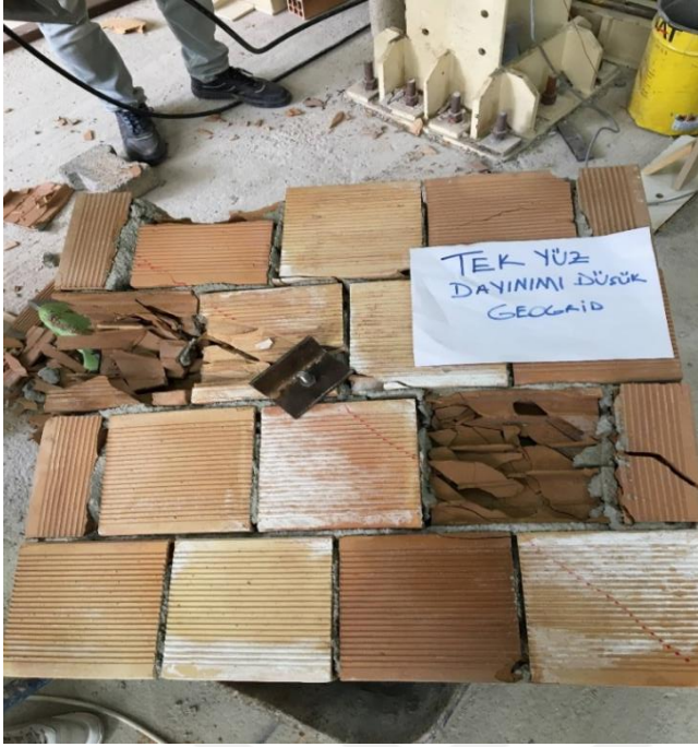
Resim 5.16. Diyagonal yükleme deneyi sonrasında tek yüzü Tür 1 ile güçlendirilmiş 2. tuğla duvar numunesinin arka yüzünde oluşan hasarlar
