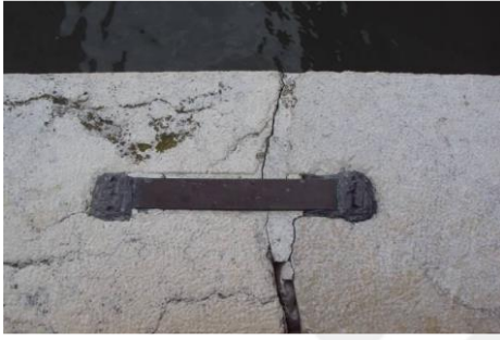
Resim 3.19. Metal bağlantı elemanın numuneye uygulanması (Koçak, 2013)
