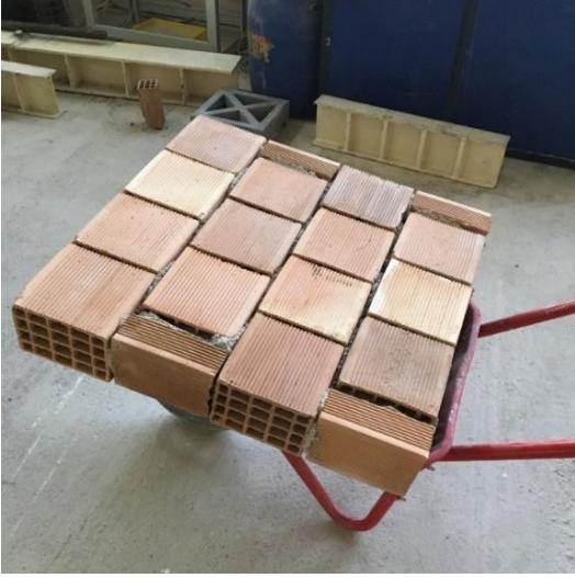
Resim 4.24. El arabası yardımıyla yükleme düzeneğinin etrafına taşınan tuğla duvar numunesi
