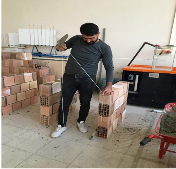
Resim 4.14. Tuğla duvarlar örülürken şakulle kontrol edilmesi
