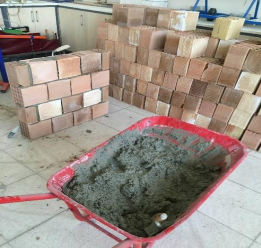
Resim 4.13.a) Tuğla duvarların örülmesi
