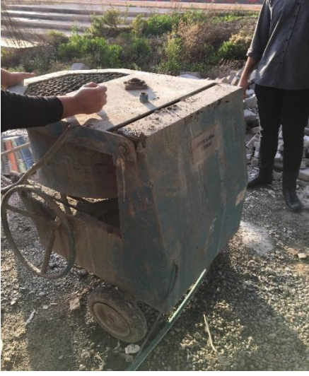
Resim 4.15. Sıva malzemelerinin mikserle yerleştirilmesi
