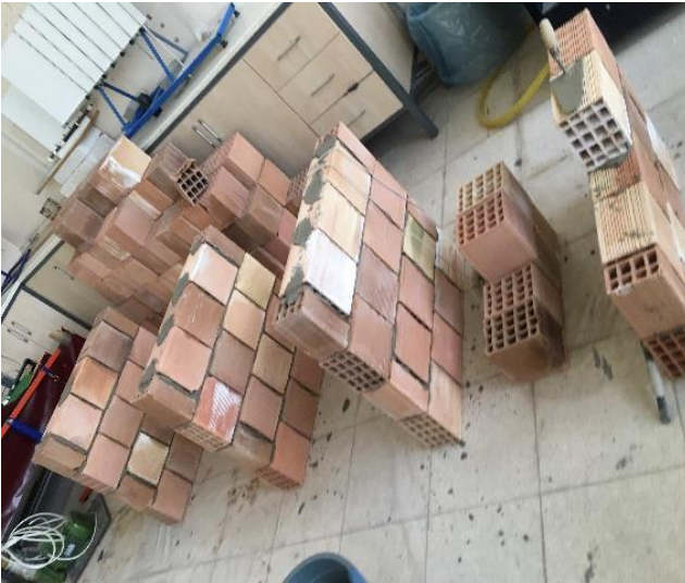
Resim 4.13.d) Tuğla duvarların örülmesi
