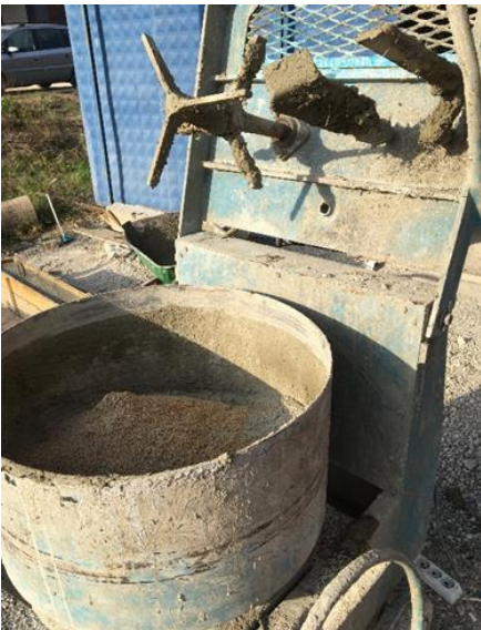
Resim 4.7. Miksere malzemelerin yerleştirilmesi
