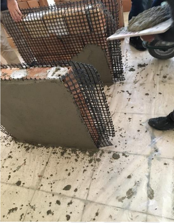
Resim 4.18. b) Çift yüze sıva ile uygulanan plastik kompozit donatı
