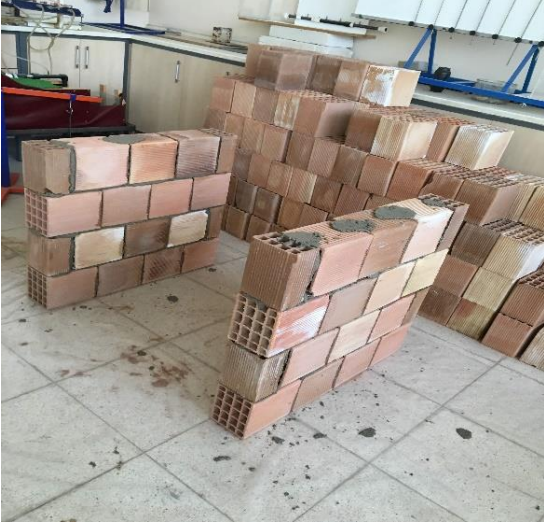
Resim 4.13.b) Tuğla duvarların örülmesi
