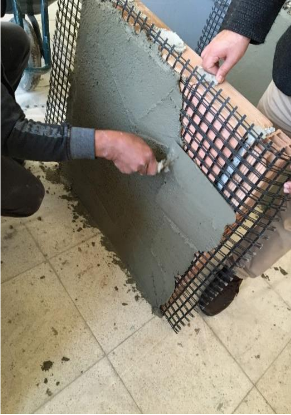
Resim 4.19. Tek yüze sıva ile uygulanan plastik kompozit donatı
