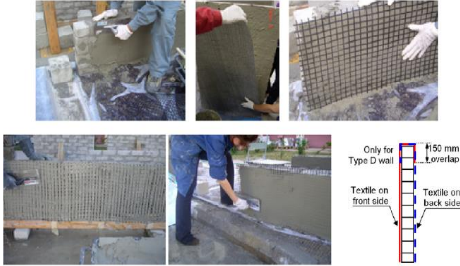
Resim 3.10. Yükleme öncesi numunelerin hazırlanması (Triantafillou, Papanicoiaou ve Lekka, 2011)
