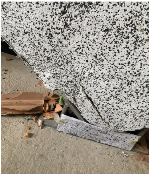
Resim 5.26. Diagonal yüklemeye sonrası tek yüzü Tür 2 ile güçlendirilmiş 2. tuğla duvar numunesinin ön yüzünde oluşan kılcal çatlaklar
