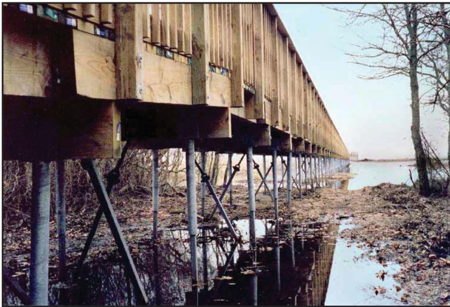
Şekil 3.11. Temelleri ıslak zemin üzerinde bulunan yapıda helisel kazık uygulaması (Yılmaz, 2016)
