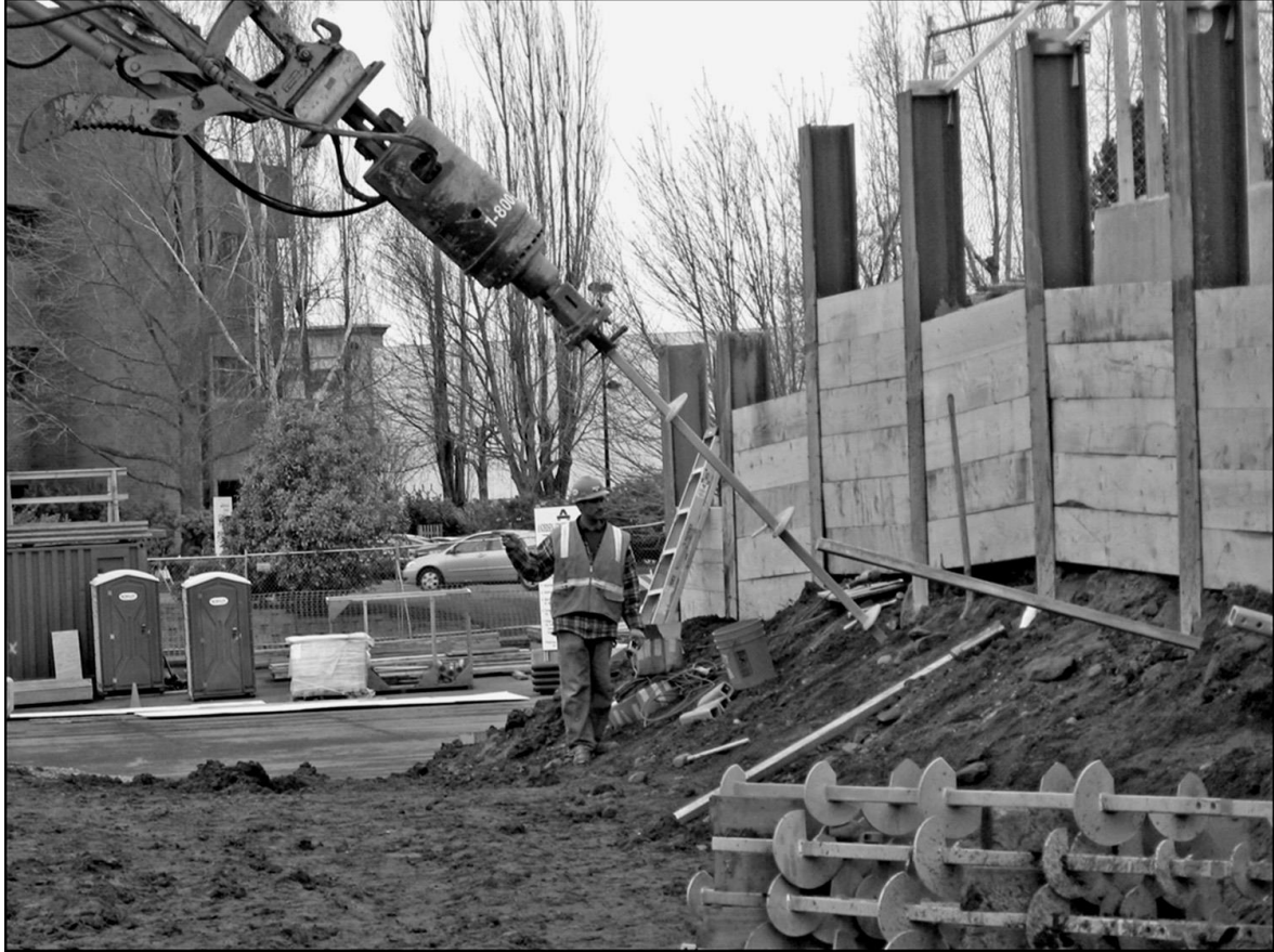
Şekil 3.12. Şevli zeminlerde helisel kazık uygulaması (Perko, 2009)
