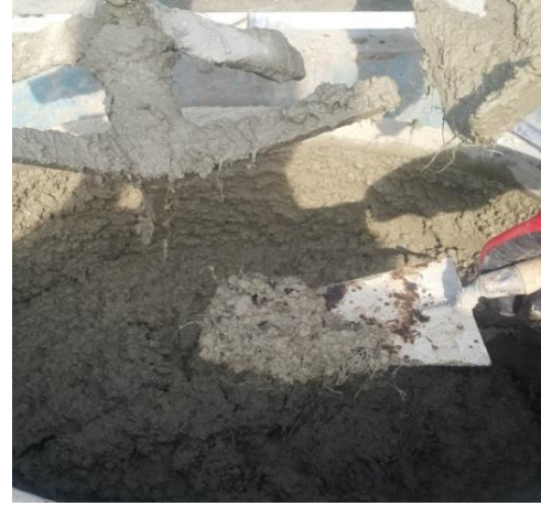
Şekil 4. MFSD katkılı beton karışımı
