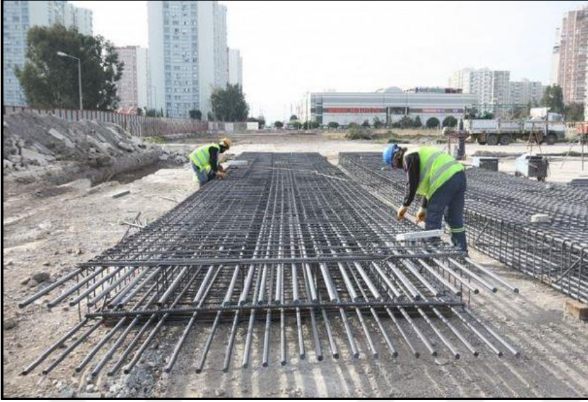
Resim 3.3. Donatı kafesinin hazırlanması (www.egezemin.com)
