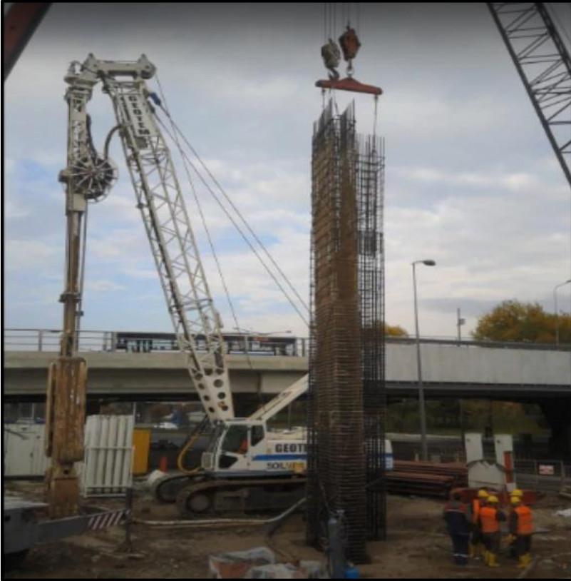
Resim 3.4. Donatı kafesinin kuyuya indirilmesi (Geotem Jeoteknik İnşaat Müh. Müş. A.Ş., 2017)
