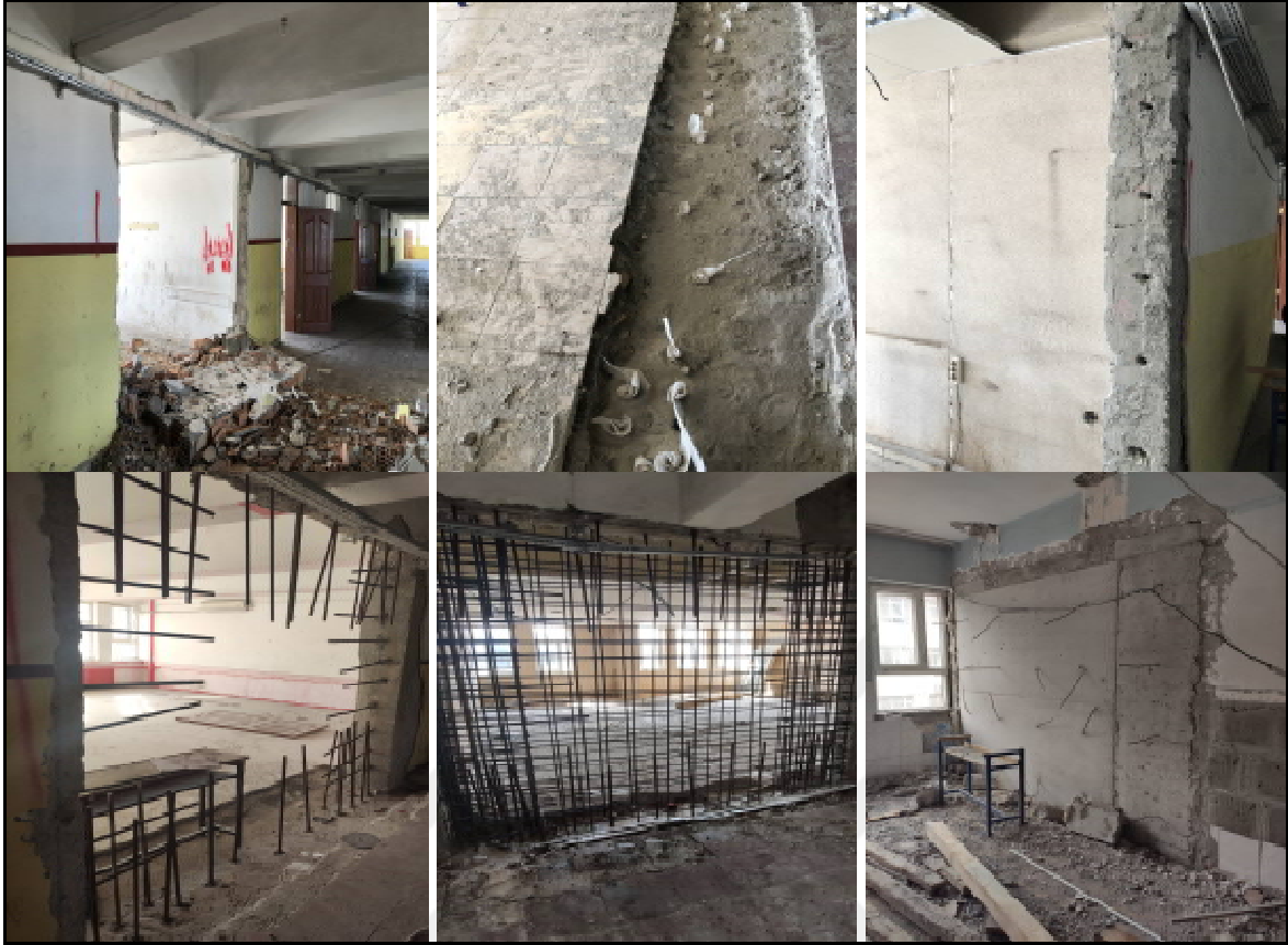
Şekil 4.5. Perde duvar uygulaması aşamaları
