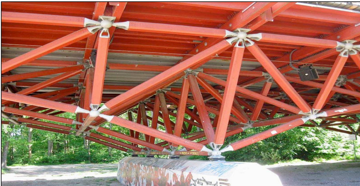
Şekil 2.24. Düğüm noktası örneği, Almanya, Thalkirchner Köprüsü
