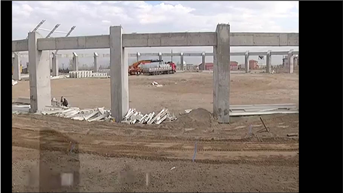
Şekil 4.16. Enkaz kaldırıldıktan sonraki saha görüntüsü
