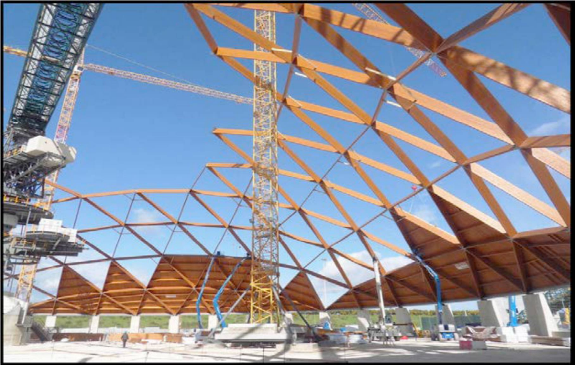
Şekil 2.22. İtalya, Brindisi'deki jeodezik kubbenin montaj aşaması
