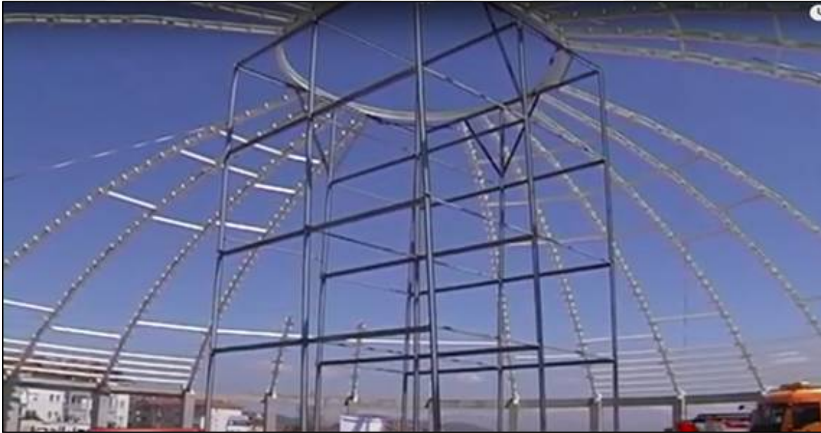
Şekil 4.10. Gökkuşbu'nin inşaatı sürerken çekilmiş bir resim
