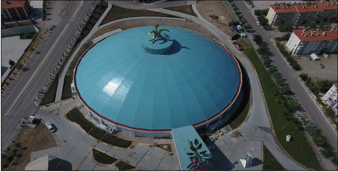
Şekil 4.8. Yapının tamamlanmış hali
