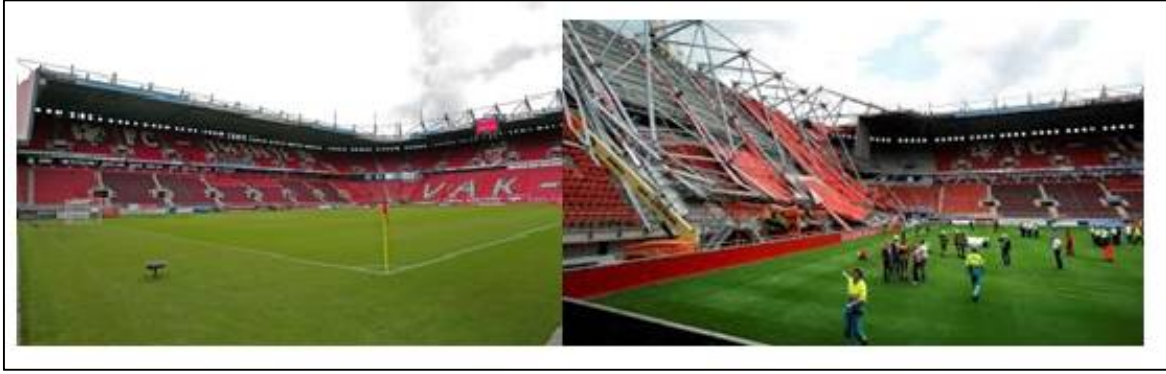
Şekil 2.8. Hollanda, Enschede'de stadyum çatısının göçme öncesi ve sonrası
