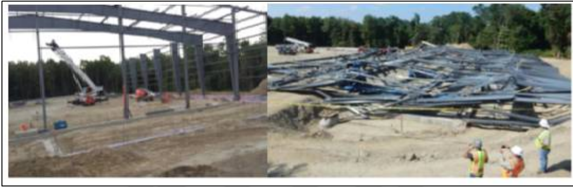
Şekil 2.6. ABD, Rhode Island'daki spor salonunun göçme öncesi ve sonrası
