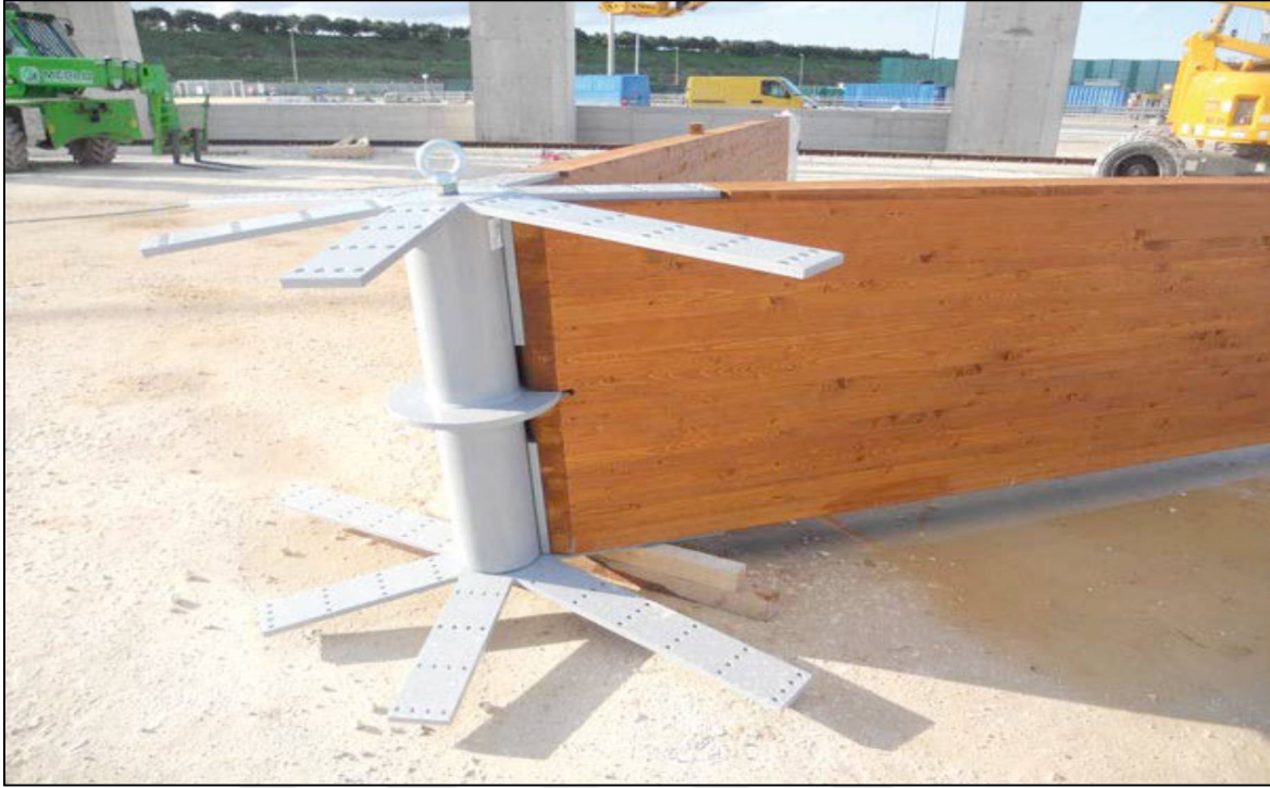
Şekil 2.23. Kubbenin montaj bağlantısının yakın gösterimi
