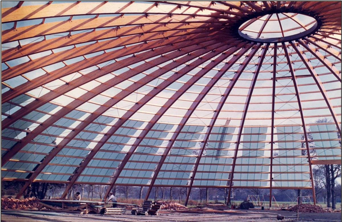
Şekil 2.16. Bell's Sports Centre içten görünüm
