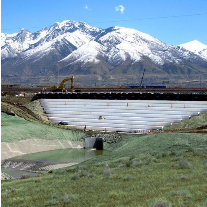
Resim 3.8. Yol dolgusunda geoköpük kullanımı (İnternet 9)
