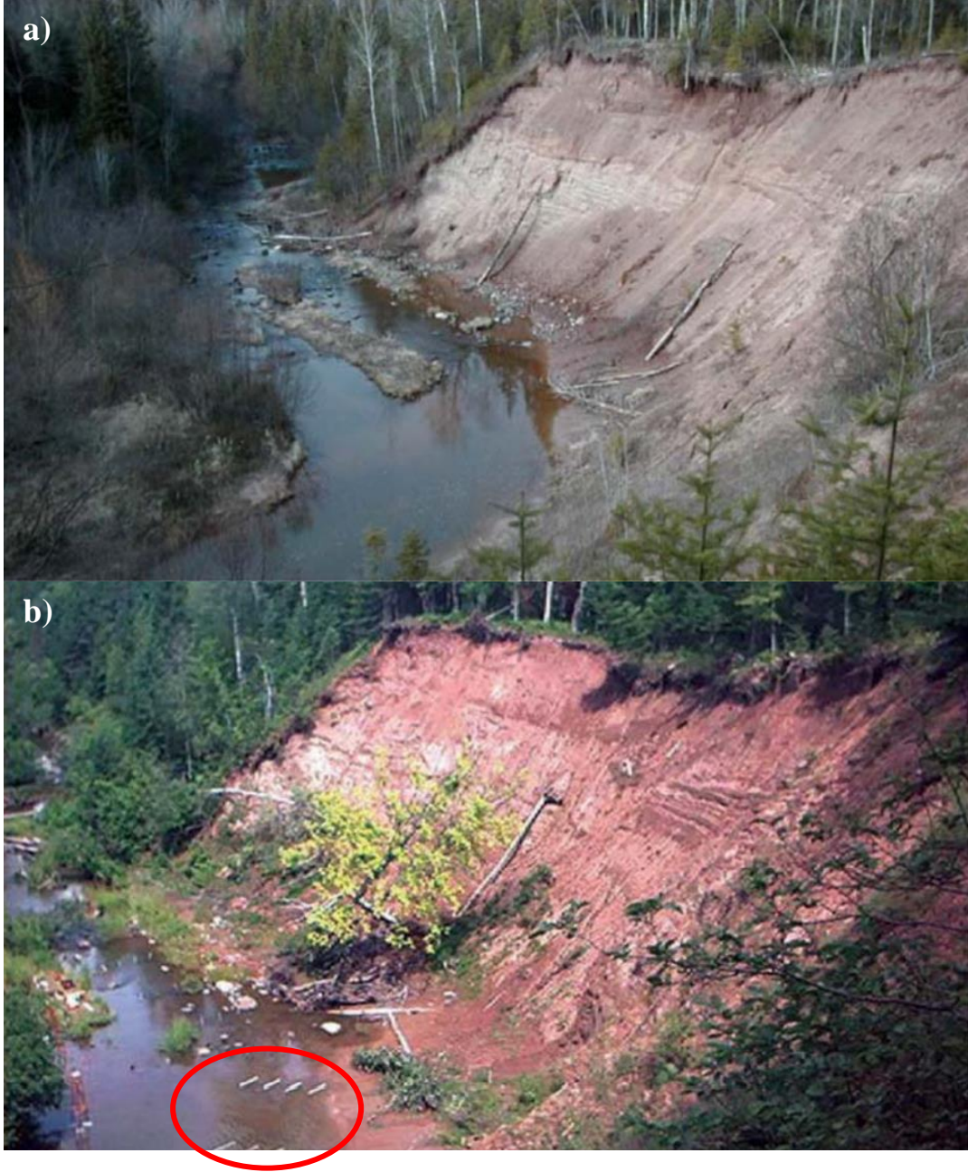
Şekil 1.3. Akarsularda oyulma örneği(a), batık kanat uygulamasından sonraki hali (b)
