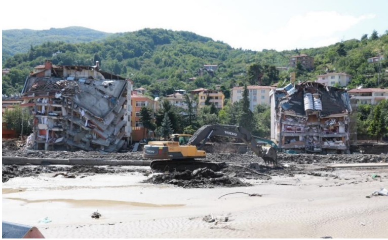
Resim 2.1. Kastamonu sel afeti sonrası binalarda ve şehir sokaklarında ortaya çıkan hasar
