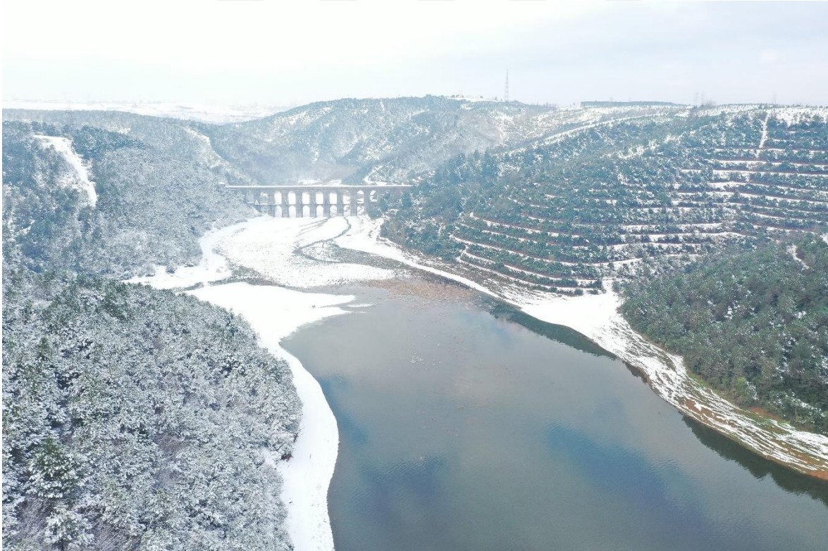
Şekil 3.1. Alibey Barajı görünüm 01/2022 (Anonim 2)
