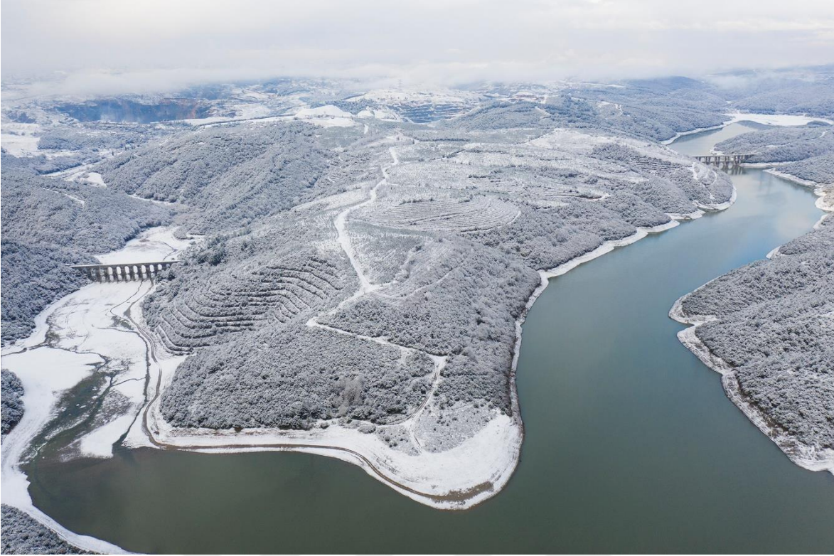
Şekil 3.2. Alibey Barajı Görünüm 01/2022 (Anonim 2)
