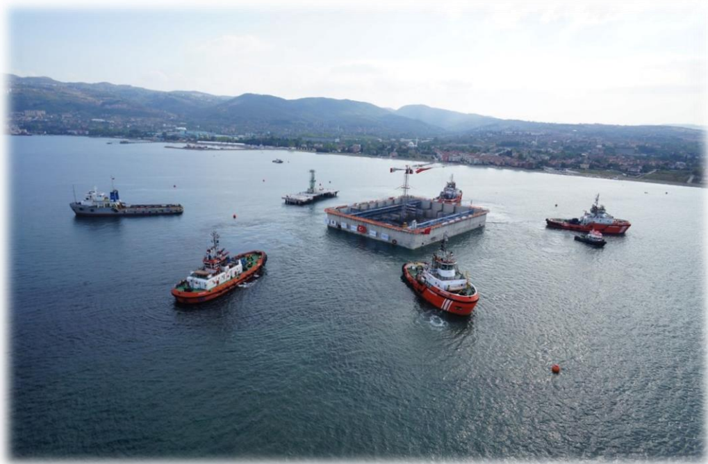
Resim 2.8. Kesonun yüzdürülmesi [17]
