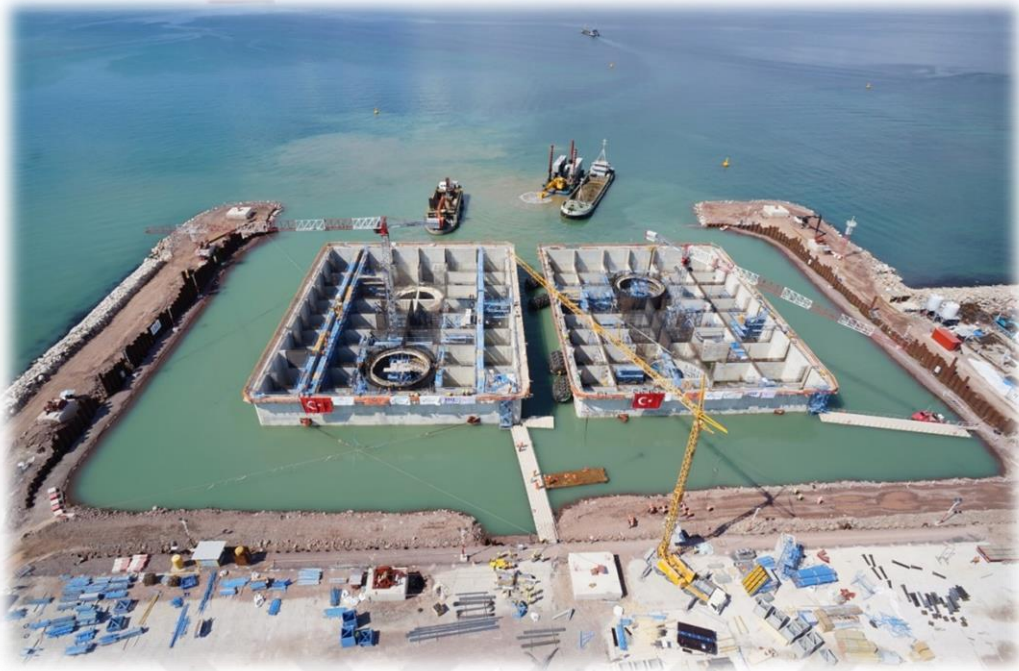
Resim 2.7. Havuz ağızının açılması [17]
