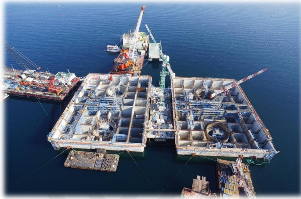
Resim 2.9. Kesonların deniz üzerinde inşasına devam edilmesi [17]
