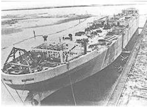
Resim 2.3. “Selma” isimli Birinci Dünya Savaşı’nda Acil Filo projesi ile ABD tarafından üretilen betonarme gemilerin en büyüğü [16]
