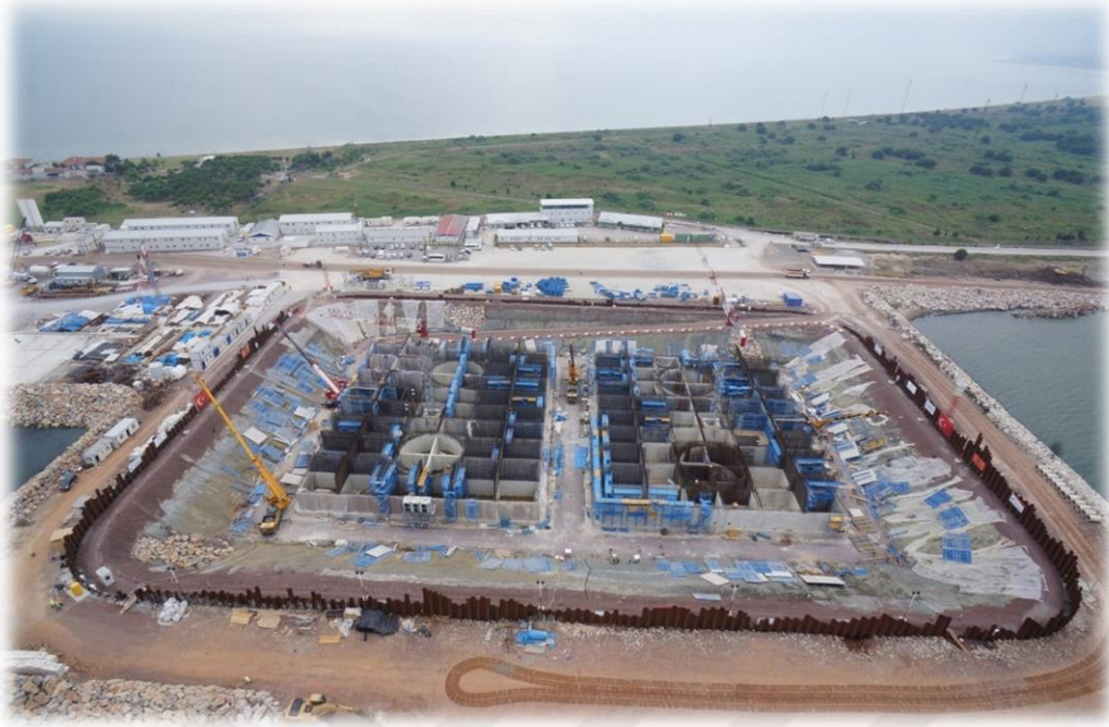
Resim 2.5. Kesonların inşa edilmesi [17]
