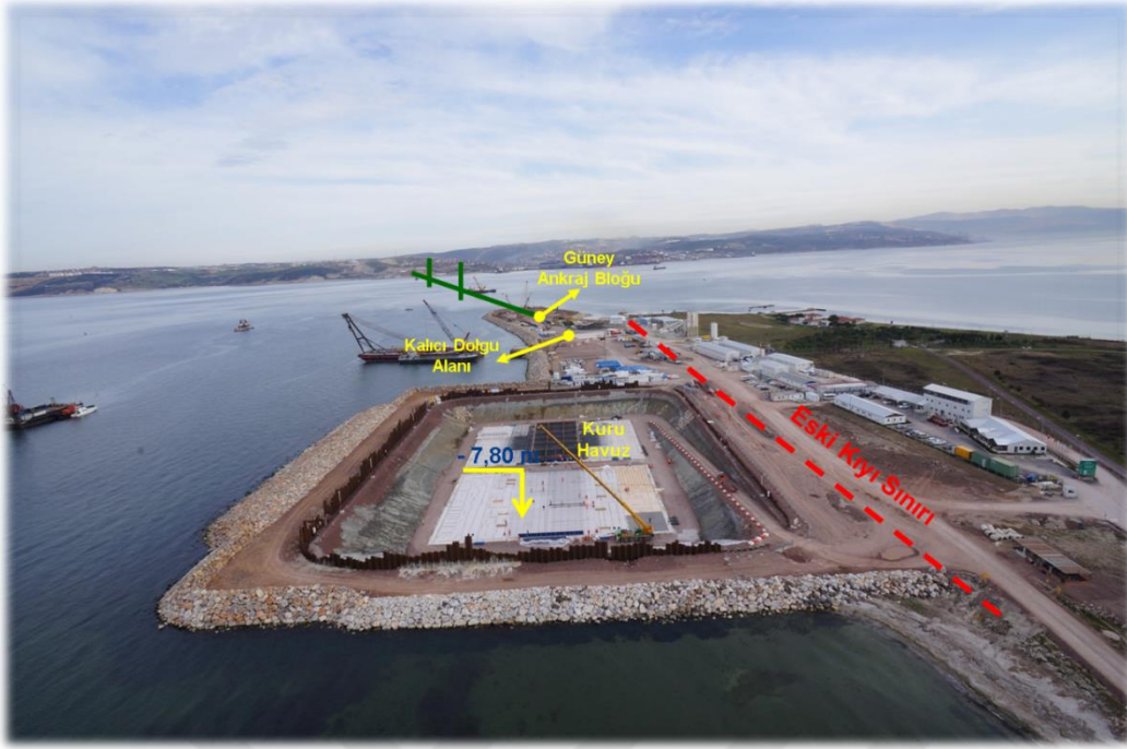
Resim 2.4. Keson imalatı öncesinde denizin doldurularak kuru havuz ortamı oluşturulması [17]
