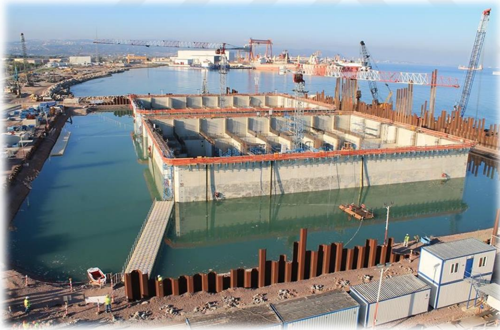
Resim 2.6. Kuru havuzun su ile doldurulması [17]
