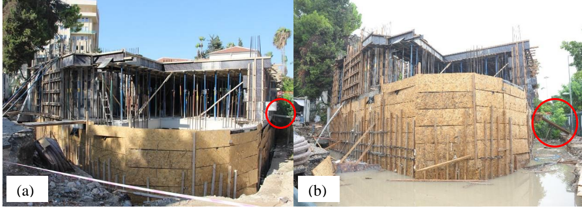
Resim 5.2. (a) Yapının inşa sırasındaki fotoğrafı, (b) Yapının yüzme sonrası fotoğrafı [6]
