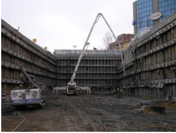
Resim 1.2. İksa kazıkları yerleştirilmiş temel çukuru
