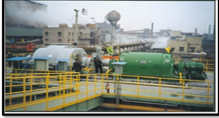
Şekil 3.3. 2.500 m 3 hacimli bir Yüksek Fırına bağlı TBT sistemi (Anonim, 2003)
