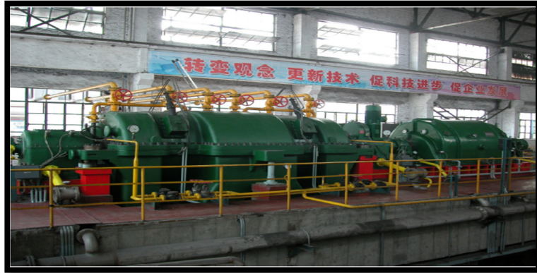
Şekil 3.5. 2x450 m 3 Yüksek Fırın için ortak jeneratör uygulaması (Anonim, 2010c)
