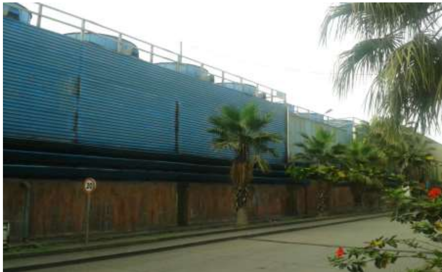
Şekil 3.9 Direkt temaslı ısı değiştirici
