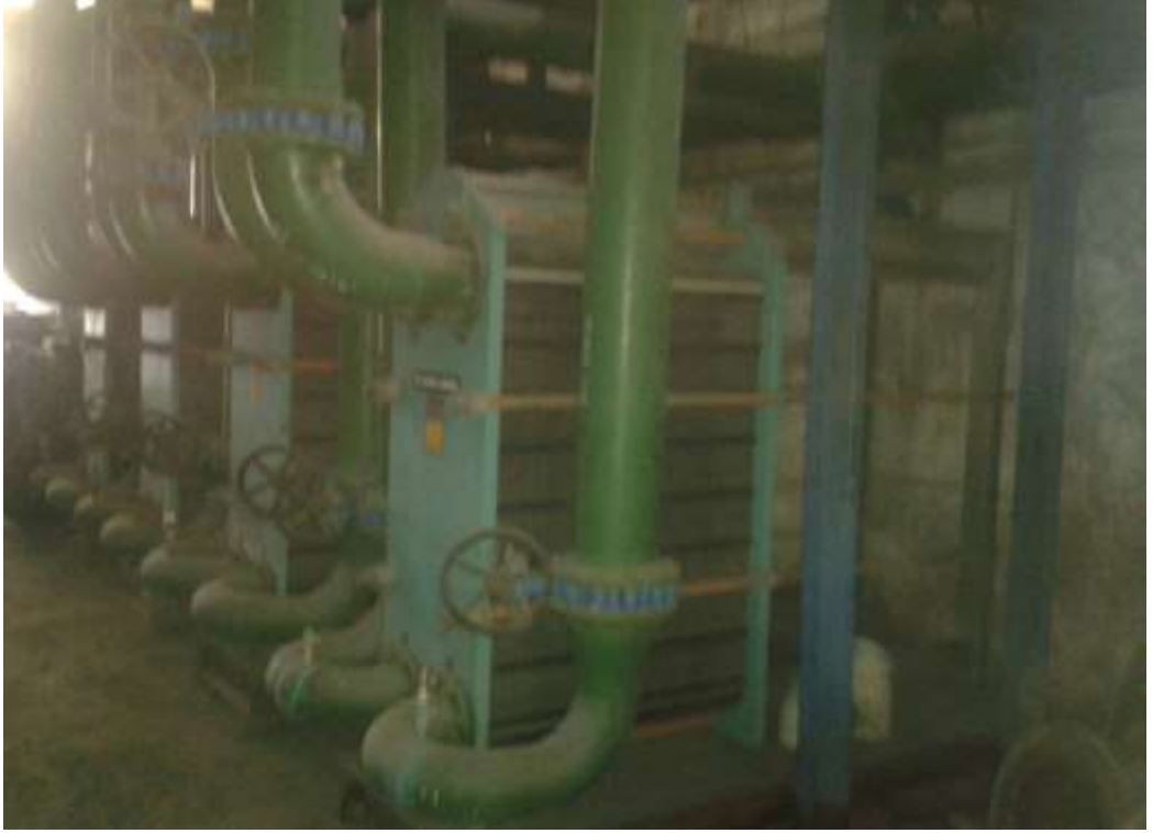
Őekil 3.10 İndirekt temaslı ısı deęiřtirici ( plakalı ısı deęiřtirici )
