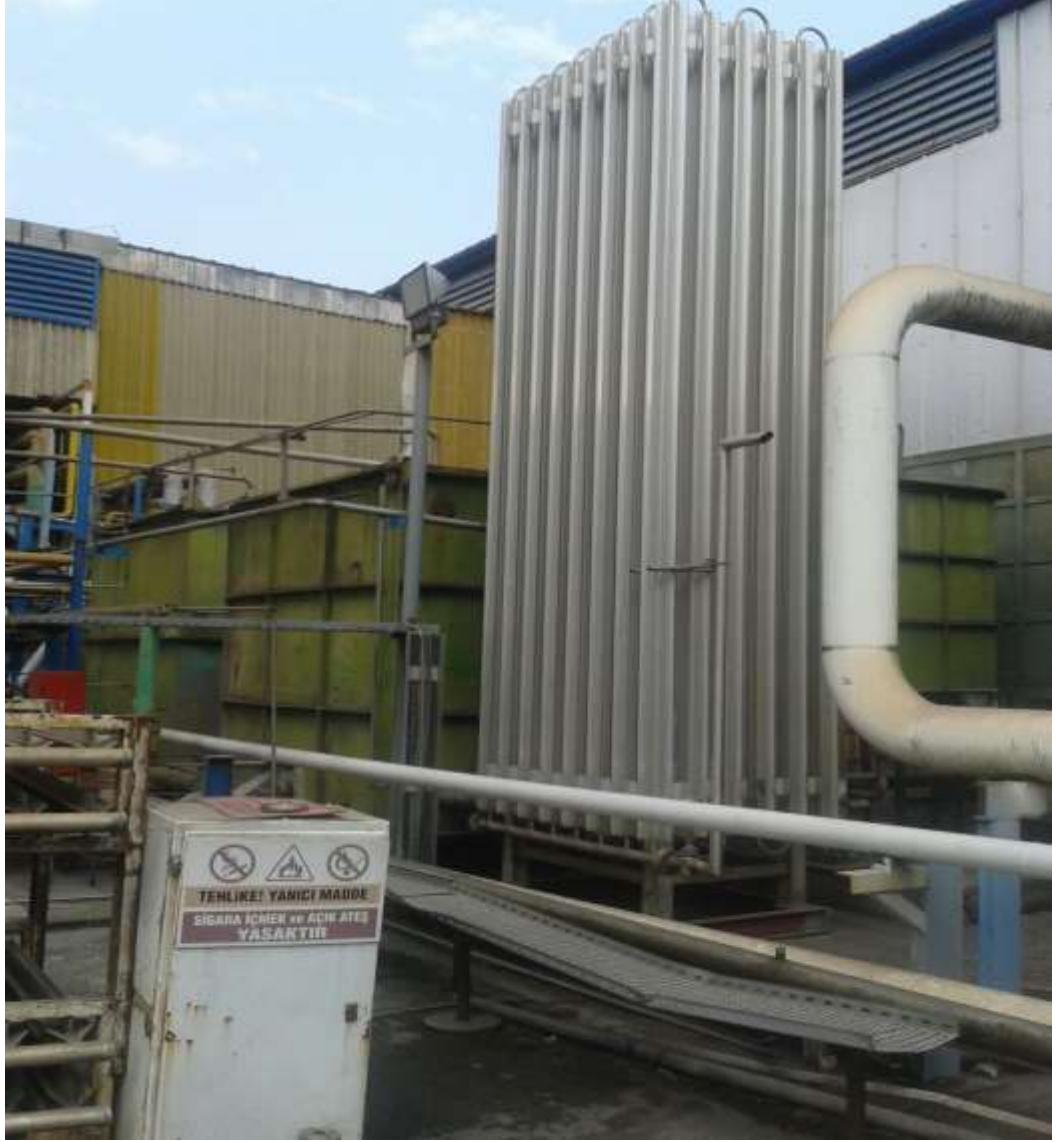
Şekil 3.11 İndirekt temaslı ısı deđiřtirici ( havalı ısı deđiřtirici )
