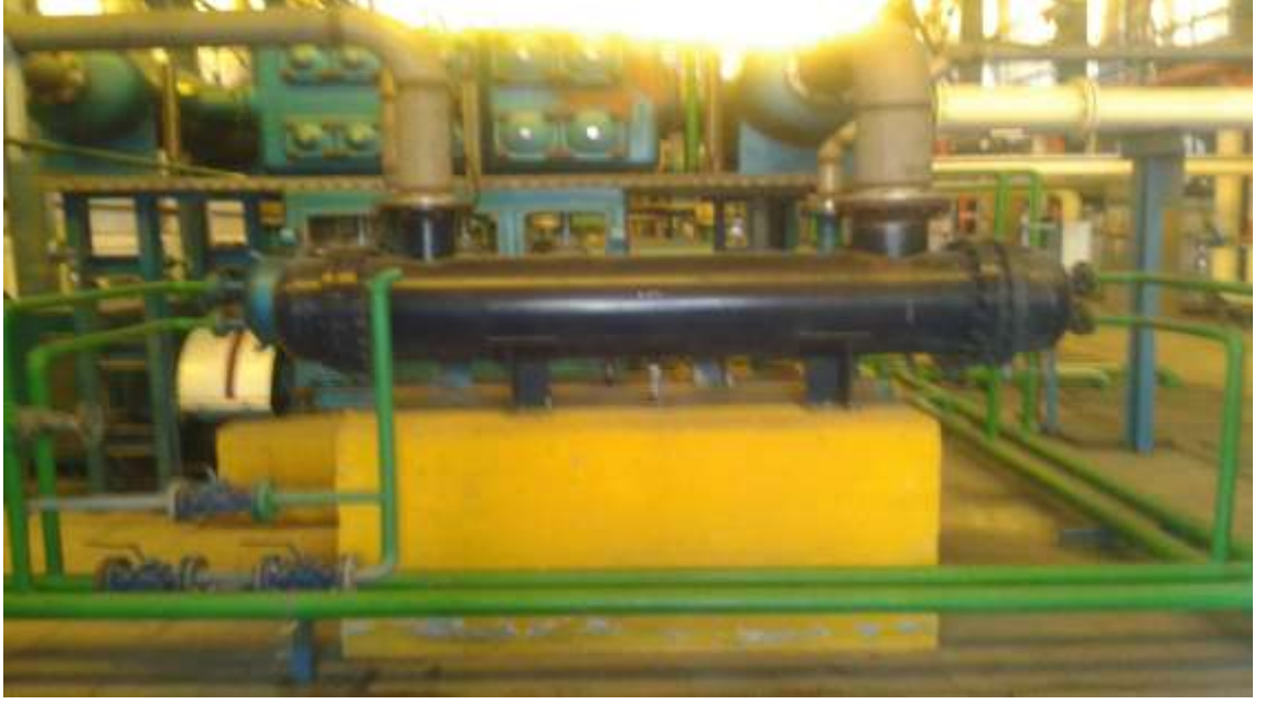
Şekil 3.12 İndirekt temaslı ısı deđiřtirici ( borulu ısı deđiřtirici )
