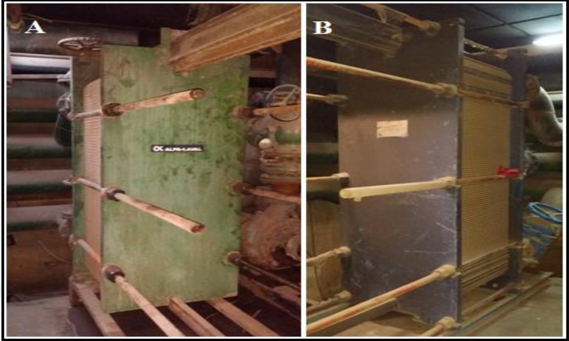
Şekil 4.1. Eşanjörlere ait resim (A) Eski eşanjör (B) Yeni eşanjör
